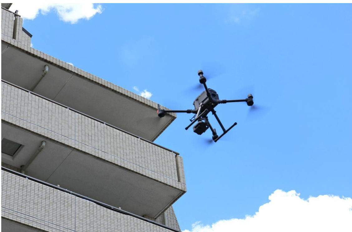
ドローンによる外壁診断と独自の AI 診断システム
